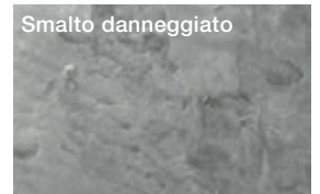
Il tradizionale bicarbonato di sodio è aggressivo
